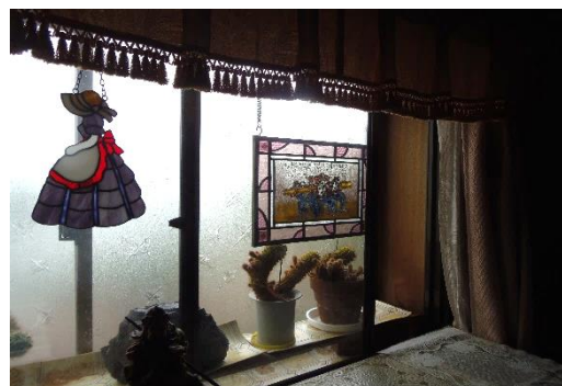
居間の窓の二重サッシ化
